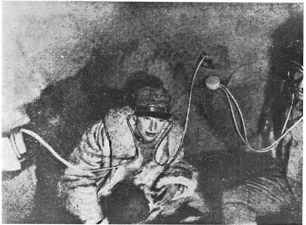
Fig. 6 - Ascolto con geomicrofono in galleria a 37 metri di profondità. Tale dispositivo serviva per udire scoppi di mine da scavo in profondità, per individuarne la posizione. Simili sensibili microfoni potevano essere utilizzati per percepire, una volta disposti in vicinanza del nemico, oltre ai rumori anche le voci. Estratto da: Lucchi: il genio nella guerra 1915-1918 - Galleri, 1936.
